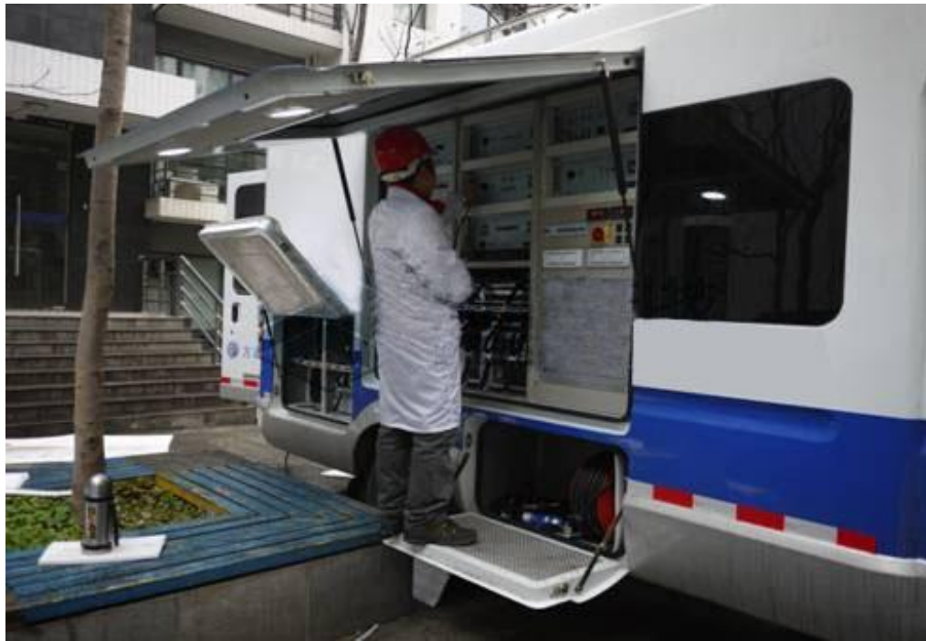
图4 KDZD接线作业平台2
