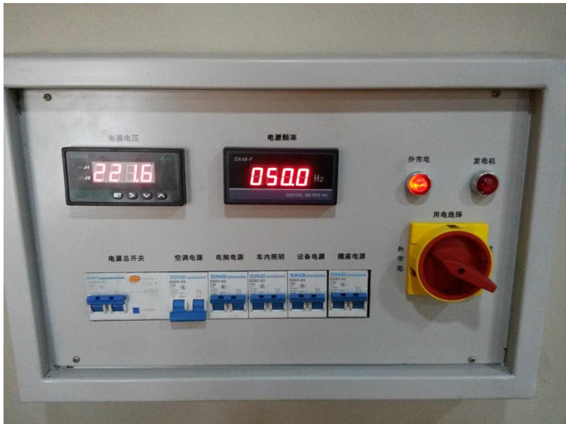
图 12 车内电气控制板图
